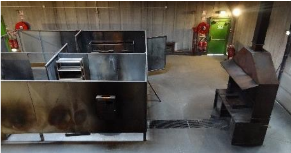
CENTRE DE FORMATION INCENDIE (91)
